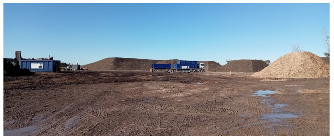
Merlons de terres issues des travaux préparatoires de la zone sud, stockées après opération de criblage, qui seront végétalisés
