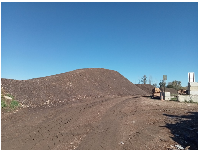
Merlon de terre récemment constitué en appui de l'existant et qui sera végétalisé
