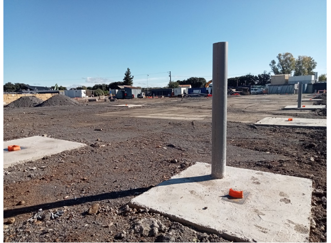
Préparation des supports pour la construction prochaine de l'auvent
