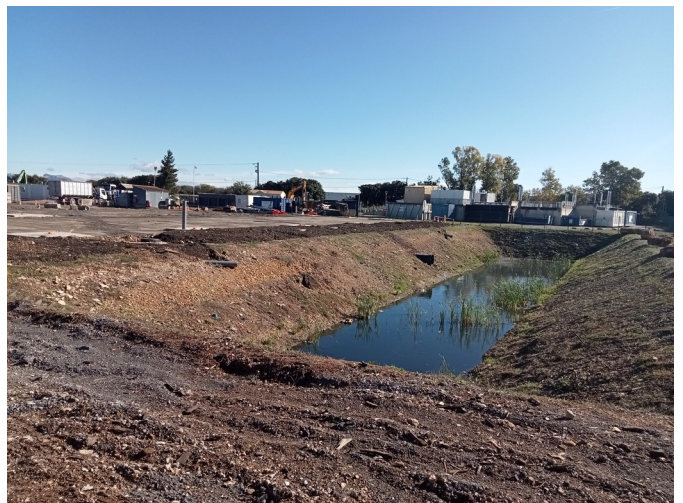
Bassin d'infiltration récemment réalisé, dont la sécurisation (grillage périphérique) reste à venir et pose d'un déboureur séparateur hydrocarbures en amont
