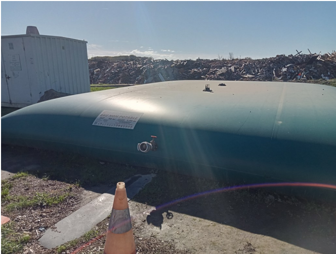
Bâche souple de 60 m 3 mise en place, complétant la réserve d'eau incendie du site (plateforme haute)
